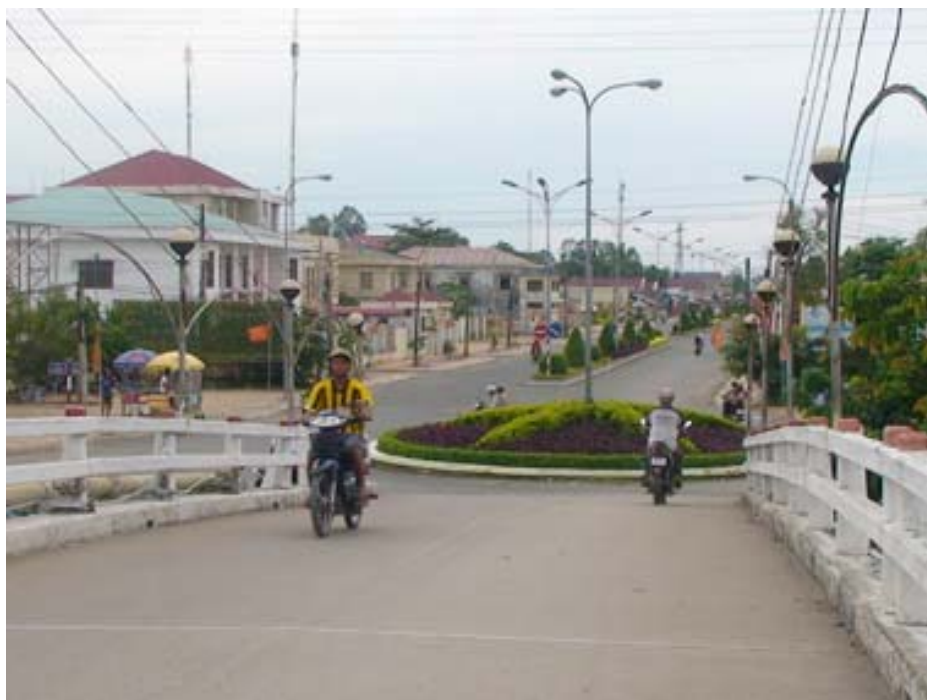
Hình 2. Các tuyến đường trung tâm thị trấn Huỳnh Hữu Nghĩa
